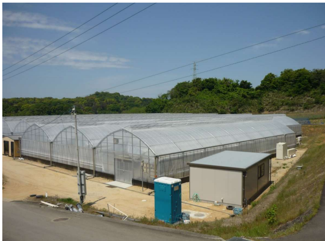
1. 土間コンクリート・床暖房事業
